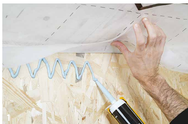
顶盖 - OSB 上的膜连接
