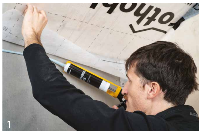
顶盖 - 混凝土上的膜连接
