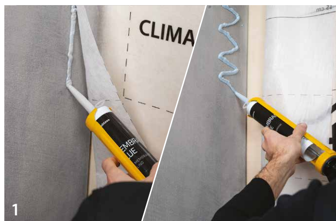
墙 - 混凝土上的膜连接
